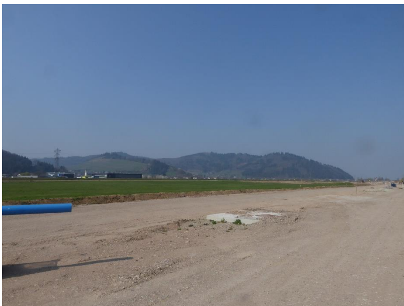
Abbildung 13: Foto Baustelle April 2019
